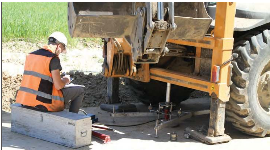
■ W poniedziałek przeprowadzono badania kontrolne wykonania betonowej podbudowy
