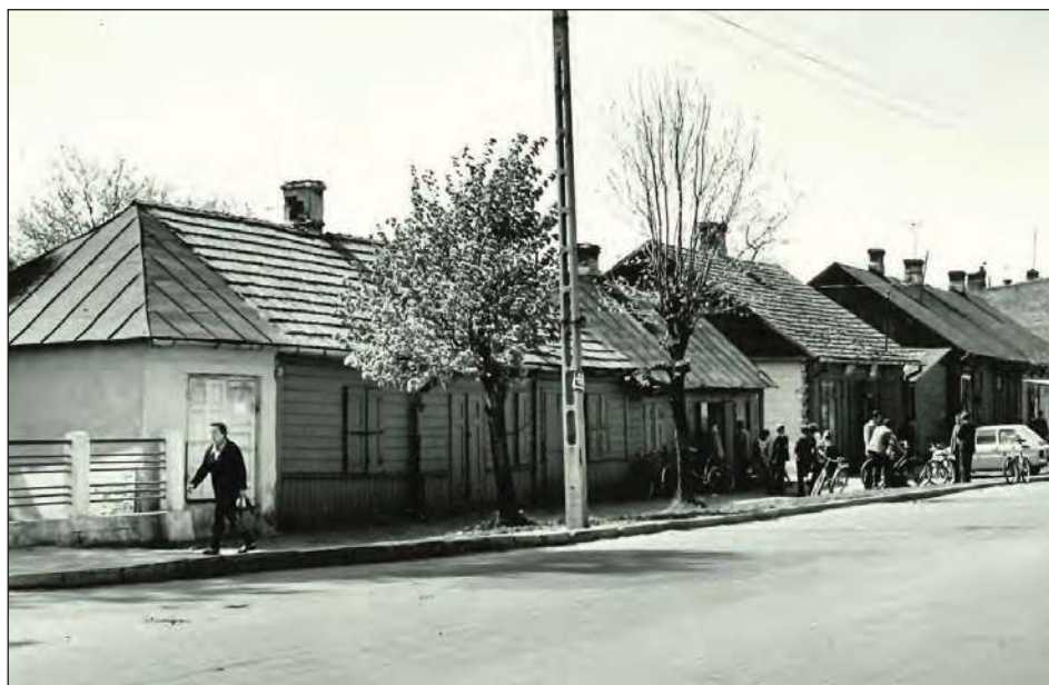
✚ Dęblin, ul. Warszawska, pierzeja lewa, posesje nr 23-29 (fot. Lubelski Wojewódzki Konserwator Zabytków)
