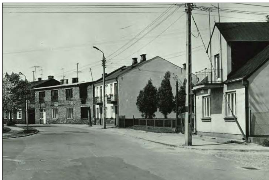
✚ Dęblin, ciąg dalszy zabudowy ulicy Okólnej (fot. Lubelski Wojewódzki Konserwator Zabytków)
