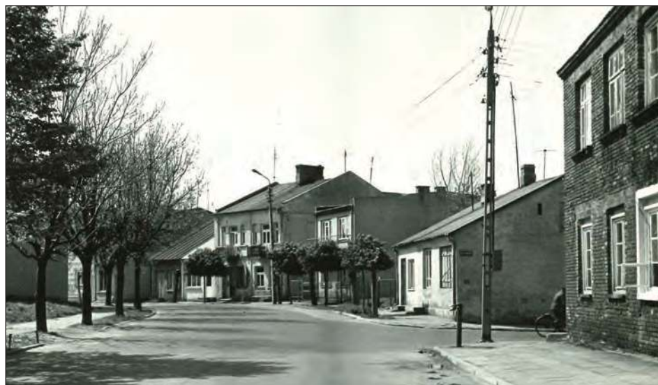
✚ Dęblin, fragment zabudowy ulicy Okólnej (fot. Lubelski Wojewódzki Konserwator Zabytków)
