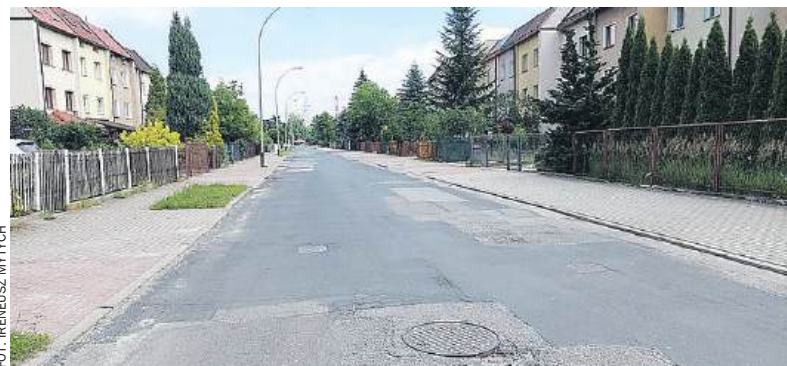
Mieszkańcy ulicy Wańkowicza od lat apeluje o remont drogi prowadzącej do ich domostw
