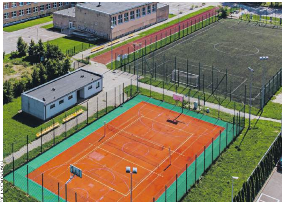
Kompleksowa modernizacja potrwa 4 miesiące
