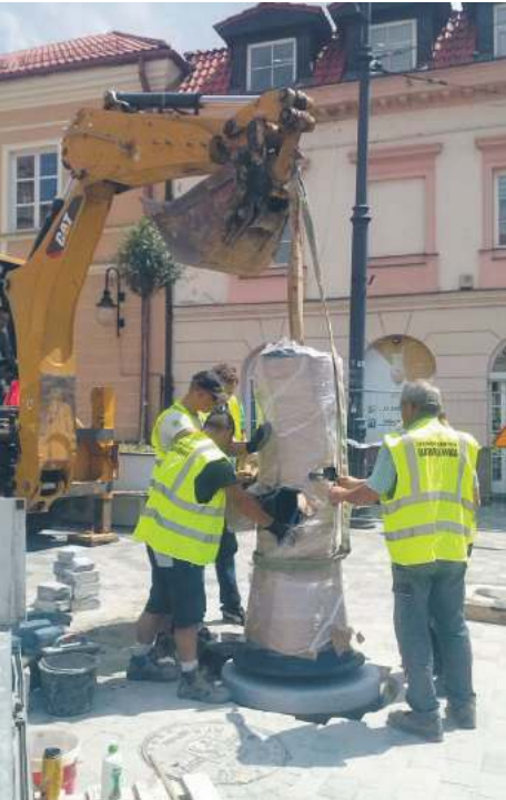
Żeliwna konstrukcja w ubiegłym tygodniu została ustawiona, ale na uruchomienie źródła wykonawca ma czas do połowy lipca
