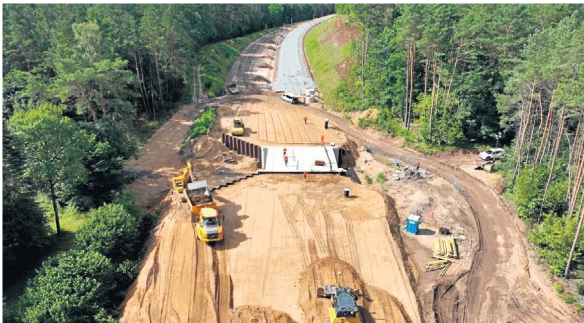
Zaawansowane prace toczą się przy budowie wiaduktów i układaniu torów
