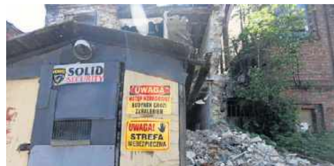
Ruiny dawnego Elanexu w Częstochowie - czerwiec 2026 r.
