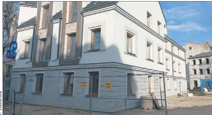
Prace budowlane przy ul. Sienkiewicza 44
