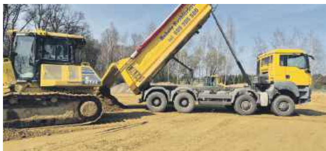
Obecnie trwają roboty ziemne, które obejmują wykonanie nasypu
