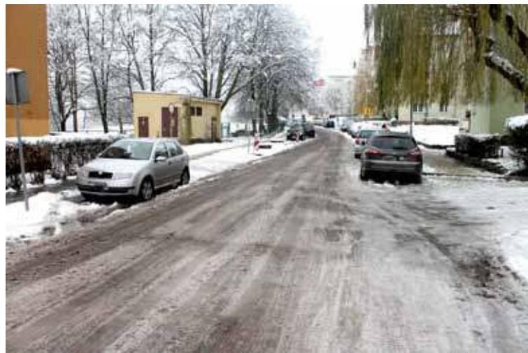
Spółka MPGK zapewnia, że nawierzchnia dróg na wymienionych ulicach nadaje się już do użycia
