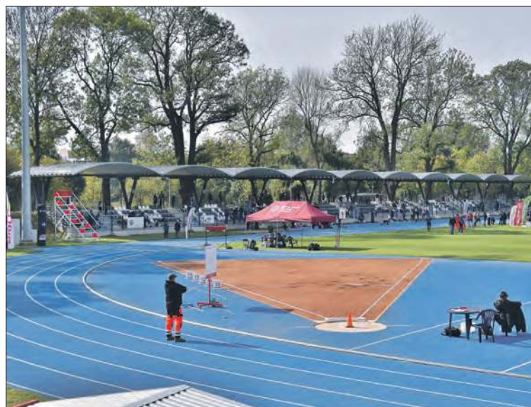
Trybuny po południowej stronie stadionu zostały zadaszone
