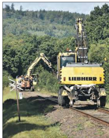
Remont linii obok przejazdu drogowego koło Wieszczyny
