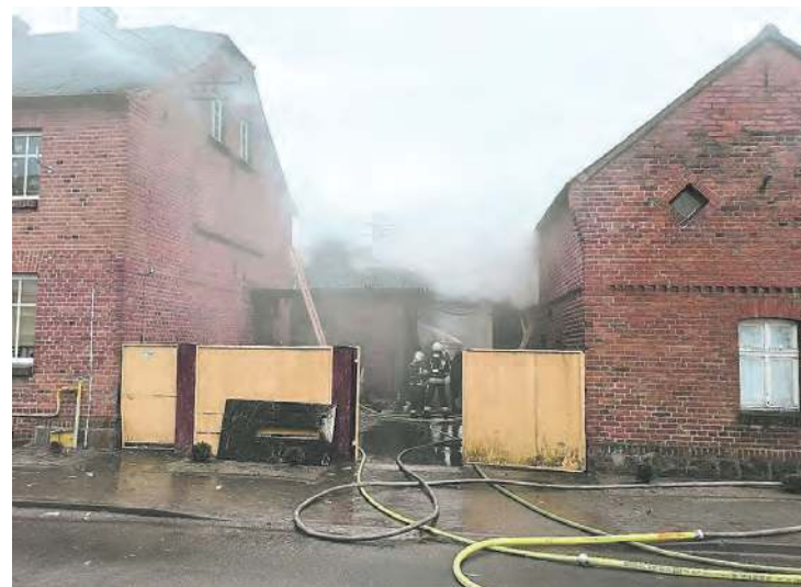
Zabudowa w centrum Lubiewa jest bardzo zwarta, ale strażakom udało się uratować okoliczne budynki.
