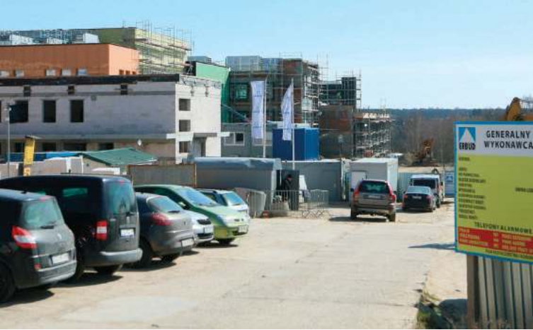
Budowa szkoły dobiega końca
