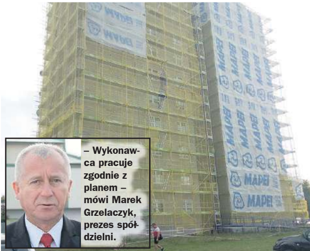
Blok numer 3 – tu prace się rozpoczęły.
