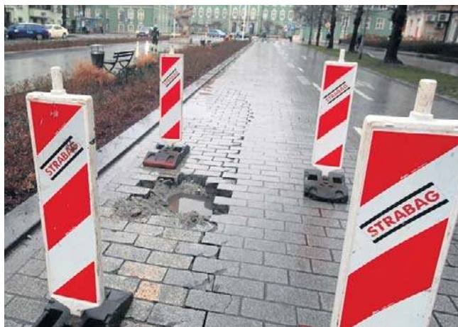
Wykonawcą prac było konsorcjum Roverpol i Rover Infraestructuras, które miało 16 miesięcy na realizację
