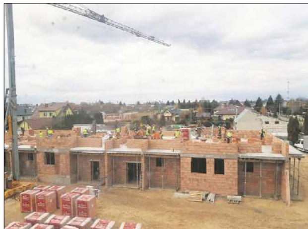
Lokale zostaną oddane pod klucz. Nie będzie w nich mebli, ale zostaną zamontowane brodziki, umywalki i krany, a także kuchnie
