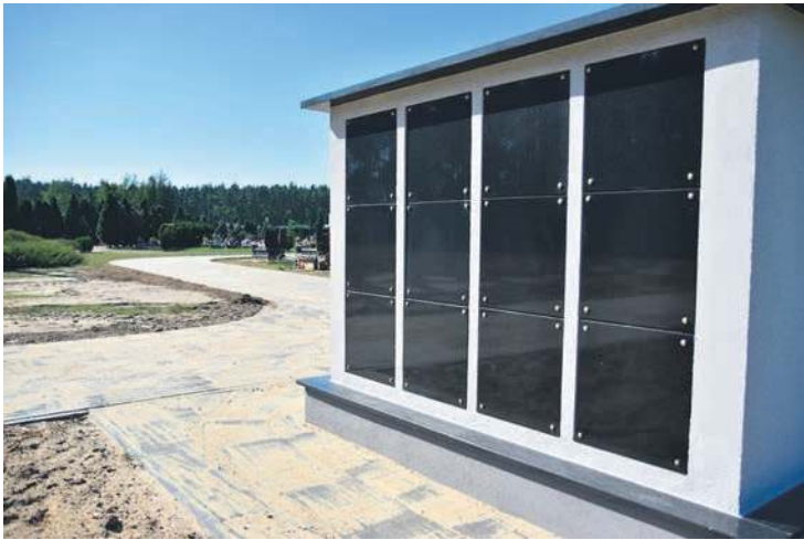
Do kolumbarium, usytuowanego na tyłach cmentarza, wiedzie już utwardzona ścieżka. Budowa samego obiektu pochłonęła nieco ponad 72 tys. zł. Kolejne moduły mają się już niejako same finansować.
