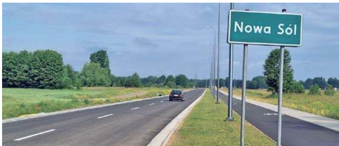
Prace przy budowie drogi trwały rok
