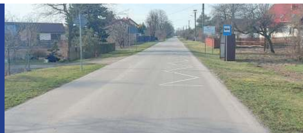
Przebudowa dróg gminnych
