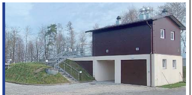
Modernizacja oczyszczalni ścieków w Starym Uścimowie
