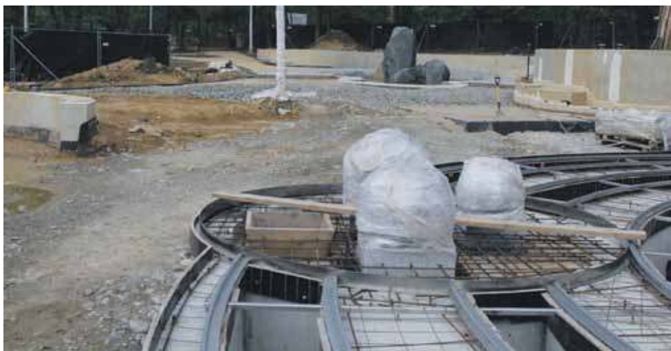
Wodny plac będzie gotowy w przyszłym roku, o ile znajdzie się wykonawca gotowy dokończyć rozgrzebaną inwestycję.
