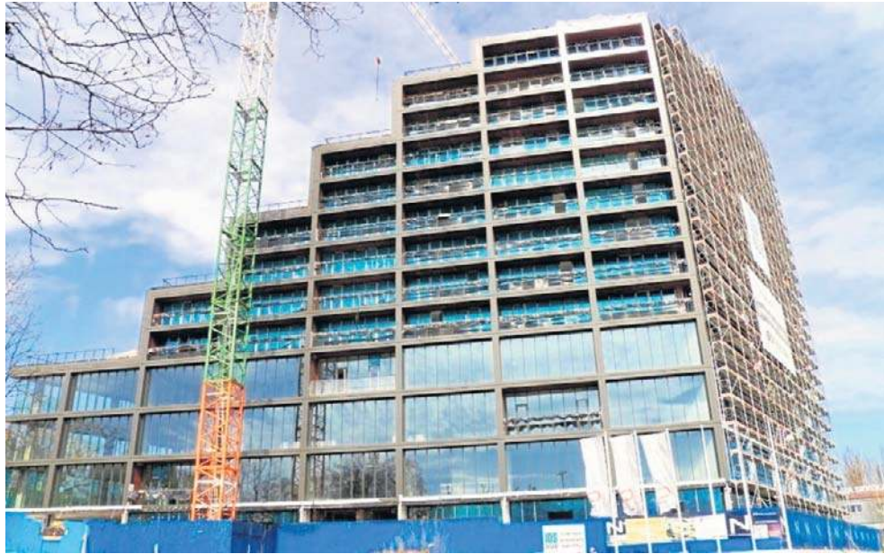
2016 rok. Trwała budowa najwyższego wtedy (15 pięter) apartamentowca w Bydgoszczy
