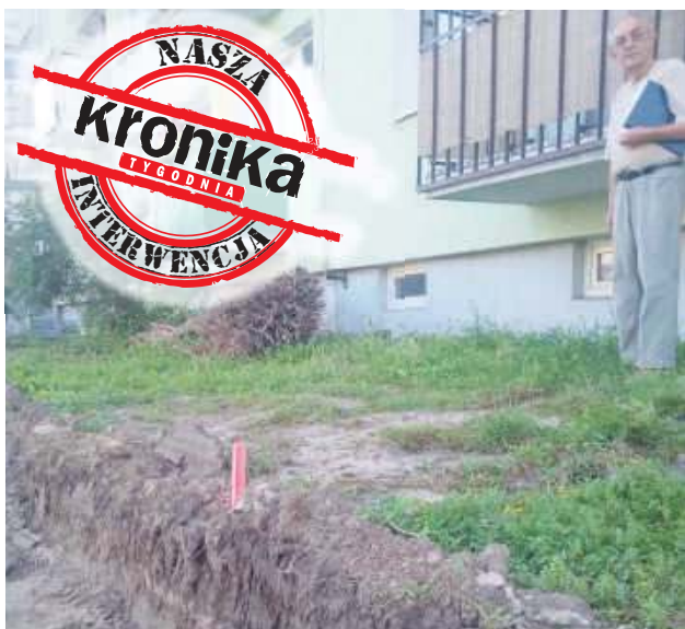
W piątek (13 sierpnia) na miejscu planowanej zatoki trwały prace budowlane.
