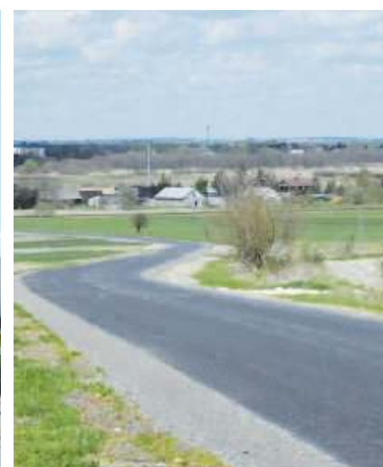
Droga gminna nr 110377L – Lipowiec-Kolonia
