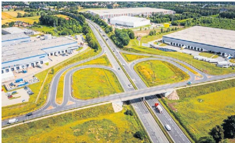
GDDKiA ogłosiła przetarg na rozbudowę S1 od węzła Brzęczkowiec na przecięciu z A4 w kierunku Bierunia
