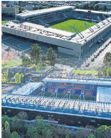
Na stadionach Cracovii i Wisły zmodernizują oświetlenie
