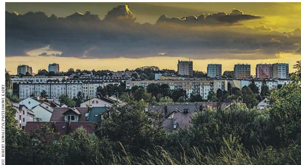
Widok na osiedle Północ w Chrzanowie
