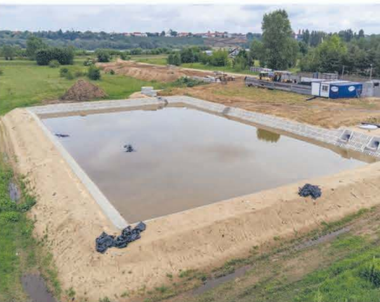
Trwa budowa zbiornika retencyjnego na osiedlu Radziwie
