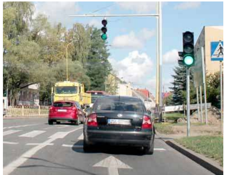
Nowe sygnalizatory na nowych słupach włączono pod koniec zeszłego tygodnia
