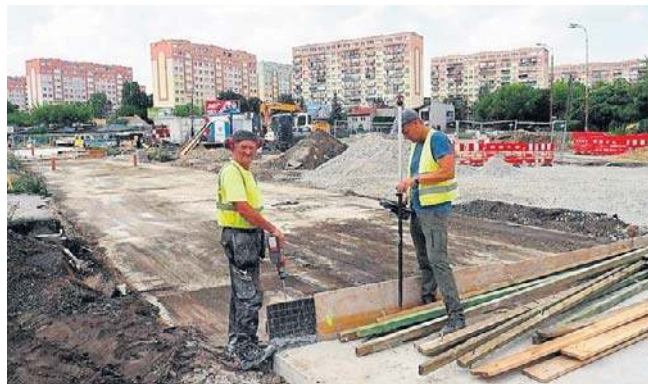
Ostatnie prace przy budowie podtorza. Na przymach leżą już szyny do montażu na nowej linii z Dąbrowy na Chojny
