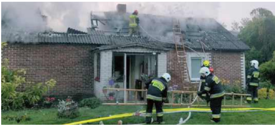
Strażacy musieli rozebrać dach budynku
