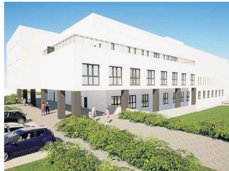
Zakończenie budowy nowego obiektu przy Al. Kraśnickiej planowane jest na przełomie 2028/2029
