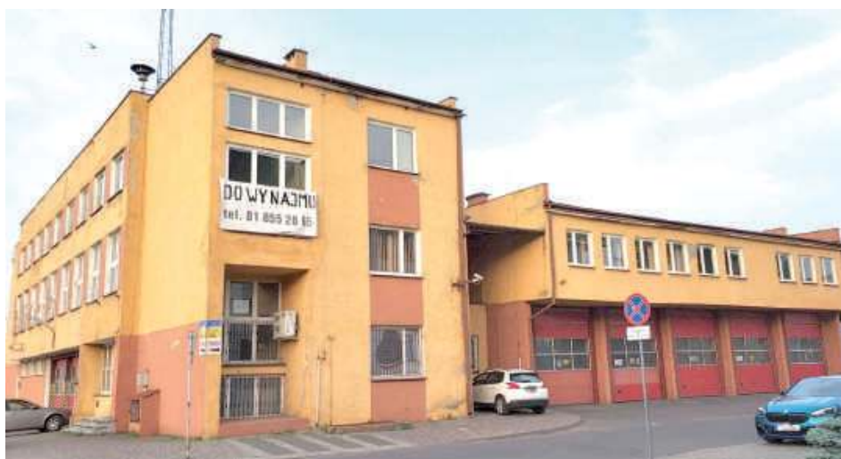
Po strażakach pozostał budynek przy ul. Jana Pawła. Jego właścicielem jest Starostwo Powiatowe w Lubartowie. Przez ponad trzy lata władze powiatu nie znalazły pomysłu na zagospodarowanie obiektu
