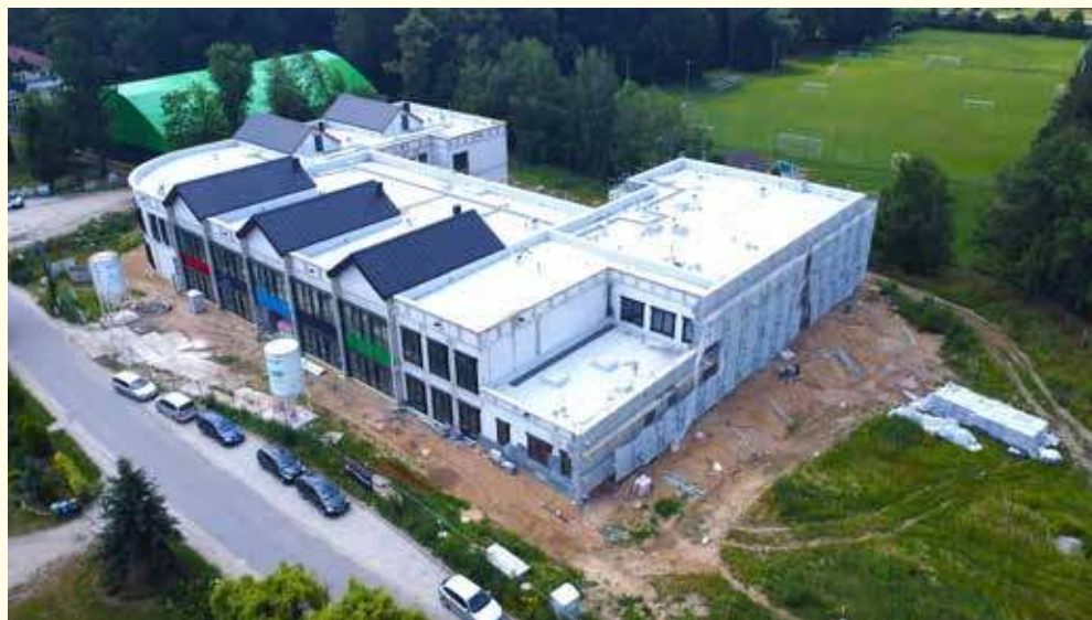
Budowa Szkoły Podstawowej w Wiszni Małej
