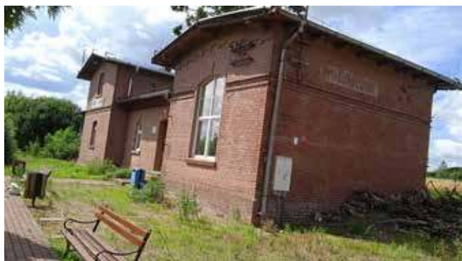
Budynek stacji Brochocin Trzebnicki.
