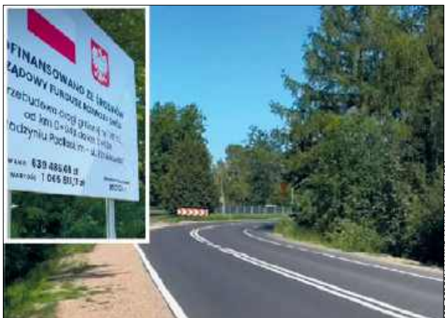
Ul. Zbultowska już po realizacji. Miasto otrzymało na odcinek od DK63 do rogatek Radzyna niecałe 640 tys. zł z Rządowego Funduszu Rozwoju Dróg
