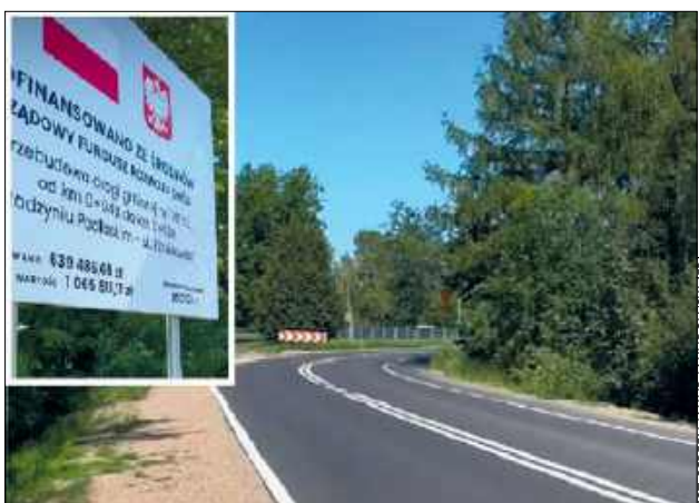
Ul. Zbultowska już po realizacji. Miasto otrzymało na odcinek od DK63 do rogatki Radzyna niecałe 640 tys. zł z Rządowego Funduszu Rozwoju Dróg
