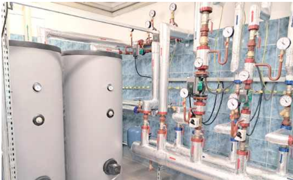
Modernizacja kotłowni obejmowała wymianę dwóch starych kotłów na trzy kotły kondensacyjne
