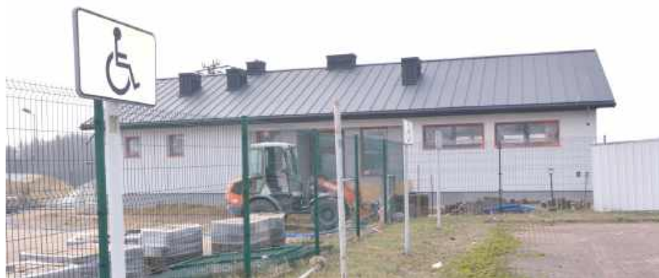
Nowy budynek przystosowany dla osób niepełnosprawnych stoi już przy boisku sportowym. Będzie w nim zaplecze sanitarno-szatniowe dla sportowców
