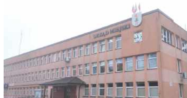
W planie jest termomodernizacja budynku urzędu miejskiego i poprawa dostępności dla osób niepełnosprawnych
