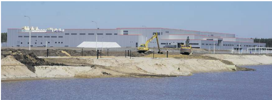
Widok na nowo powstałe budynki SK Nexilis oraz techniczny zbiornik retencyjny na terenie nowej strefy
