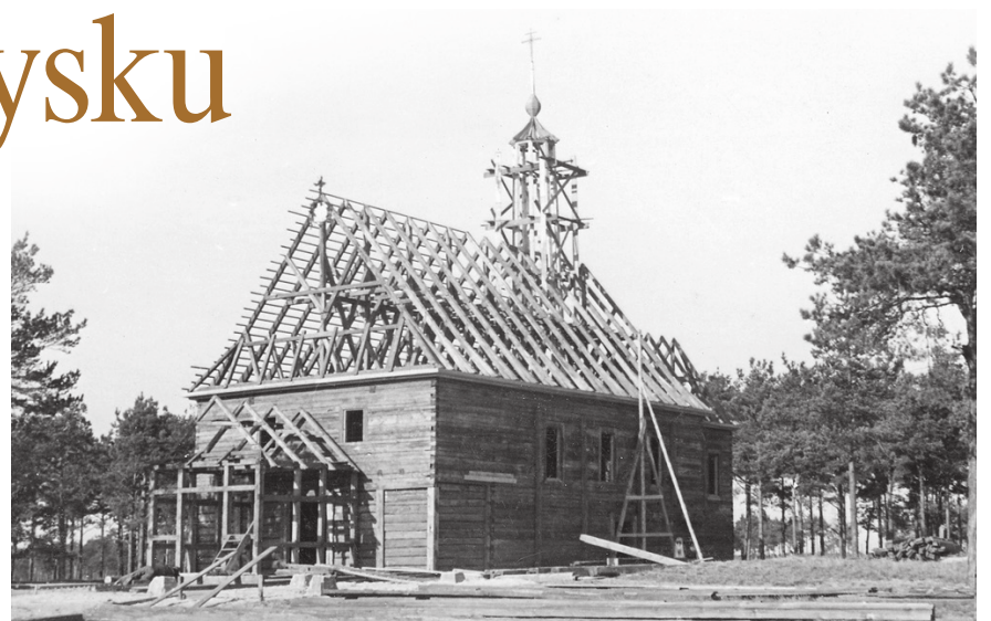
Montaż pierwszego kościoła w Stalowej Woli
