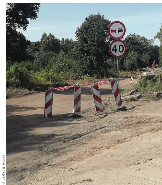
Przebudowa drogi zablokuje dojazd do sklepu
