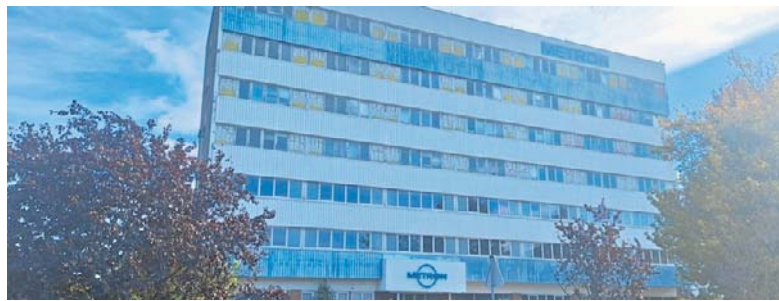
Biurowiec przy ul. Targowej 22 jest przeznaczony na cele publiczne
