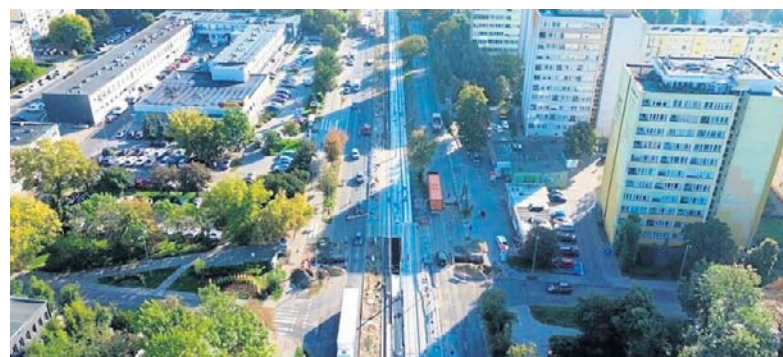
Na ulicy Kościuszki trwa wymiana asfaltowej nawierzchni
