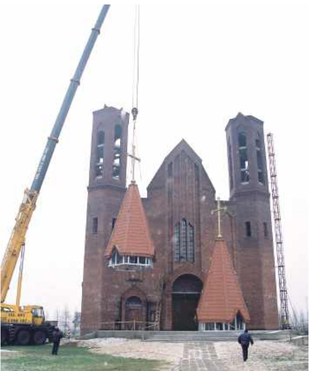
Budowy kościoła podjęła się firma inż. Waldemara Nieściora i pana Zbigniewa Markowskiego ze wsi Biała k. Radzyna Podlaskiego. Inspektorem nadzoru został Marian Pękała. Poza zawodowymi budowlancami wiele prac było wykonywanych przez parafian
