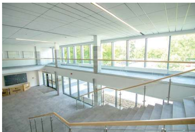
Tak prezentuje się hol zmodernizowanego Domu Chemika. Na razie jest nieco pusty, bo wyposażanie trwa
