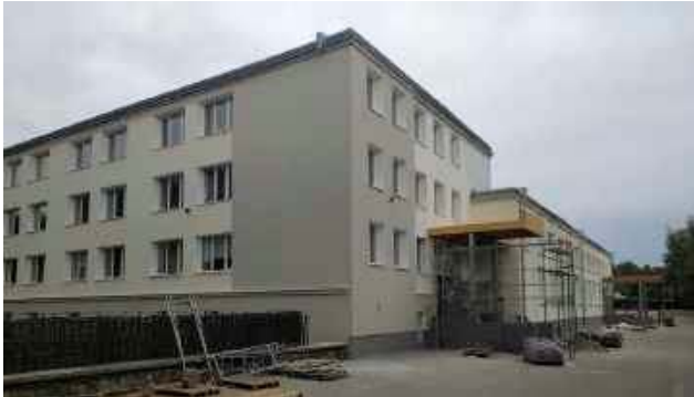
Gruntowny remont obiektów Zespołu Szkół Budowlanych oraz Bursy Szkolnej nr 8 przy ul. Słowiczej dobiega końca
