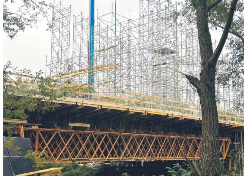
Budowa przeprawy mostowej
