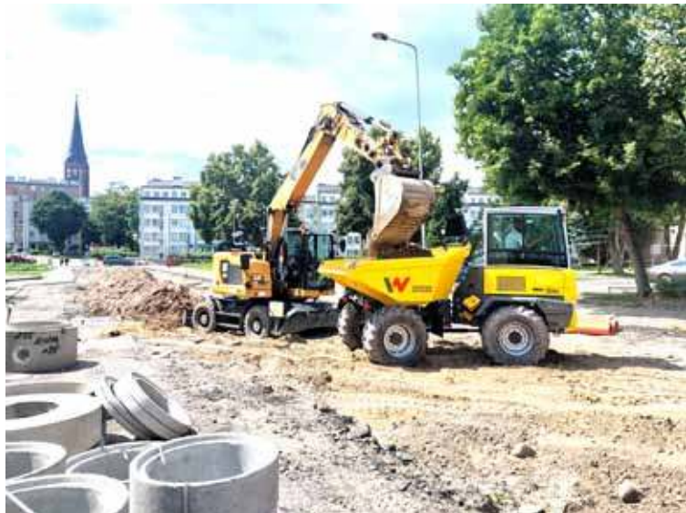
Główny remont ma poprawić komfort jazdy oraz ruchu pieszych na tej drodze
