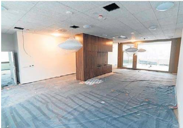
Budowa hospicjum kosztowała blisko 38,6 mln zł. Zakończenie robót planowane jest na styczeń 2026 r.
