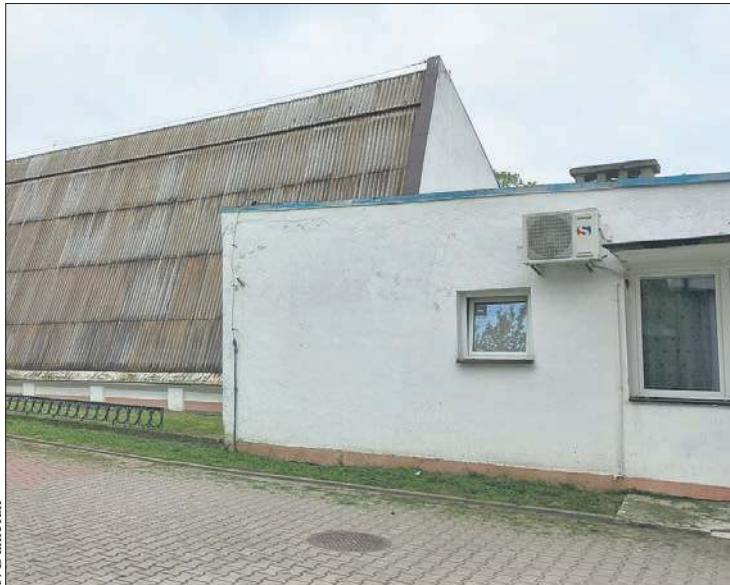
Po raz drugi nie udało się wybrać wykonawcy wyburzenia pływalni Kobylanka i wybudowania w jej miejscu parkingów
