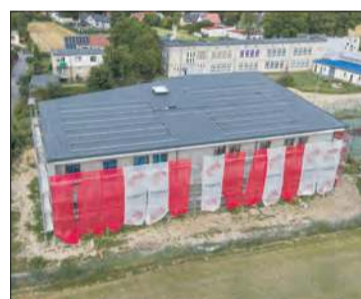
Aktualny stan budowy przedszkola w Lubrzy
