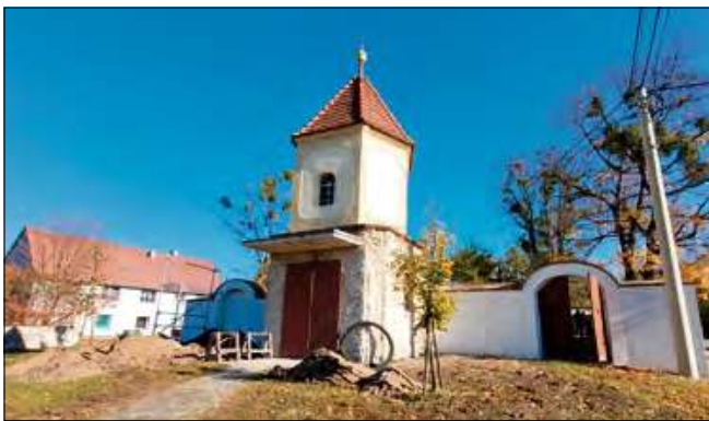
Kapliczka w Choruli jest w trakcie remontu.
