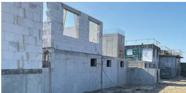
Budynek nr 3, klatka pierwsza
