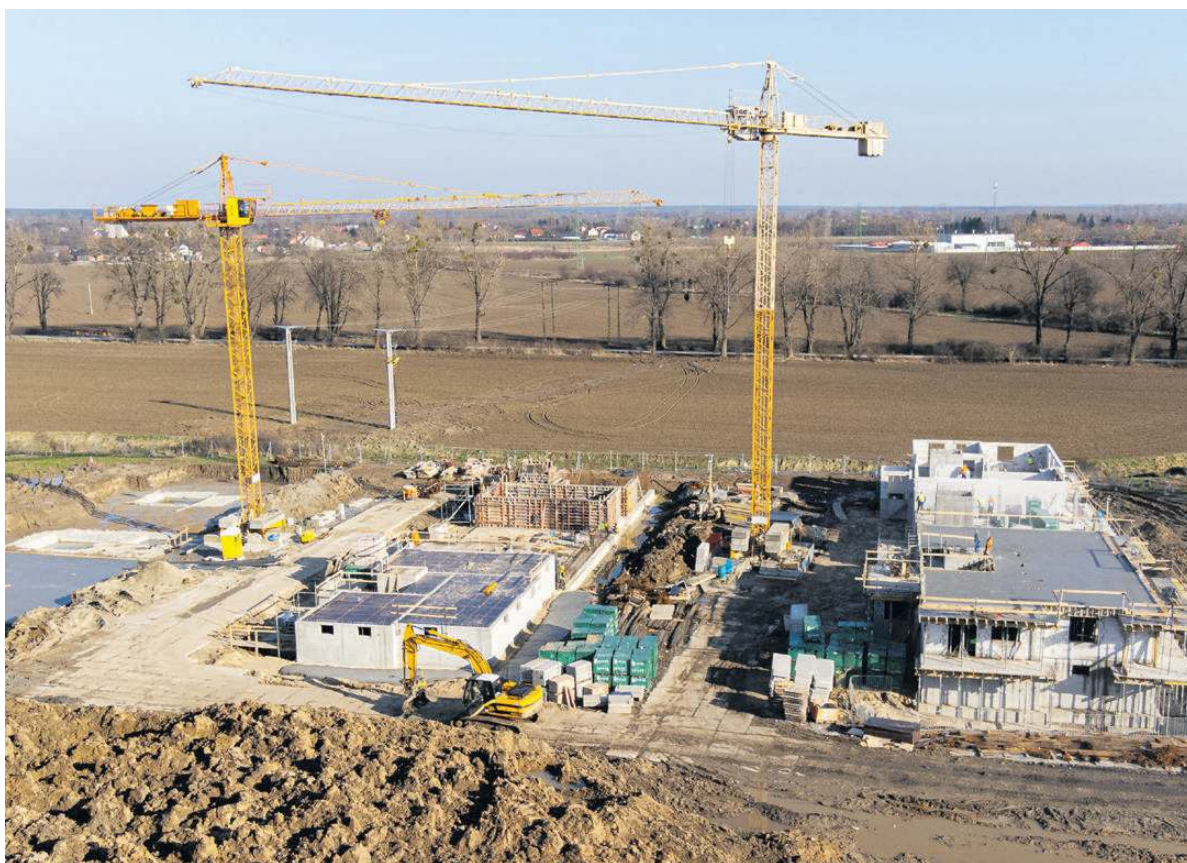
Plac budowy z lotu ptaka
