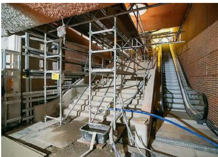
Budowa stacji C04 Bemowo | fot. Um.warszawa.pl/d
