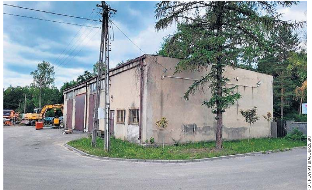
Budynki zaplecza technicznego Powiatowego Zarządu Dróg Publicznych w Białobrzegach będą remontowane.
