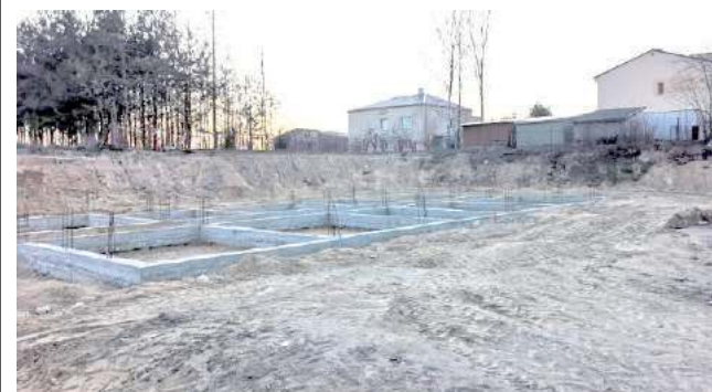
Tak wyglądał plac budowy w grudniu 2019 r. Wykonawca inwestycji nie zrealizował nawet 20 procent planu rocznego
