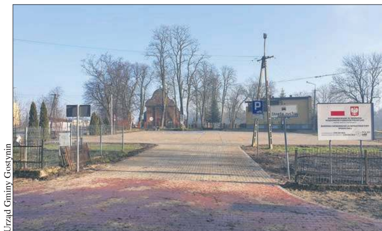
W ramach zadania „Budowa i modernizacja infrastruktury społecznej” wykonano m.in. parking w miejscowości Sokołów
