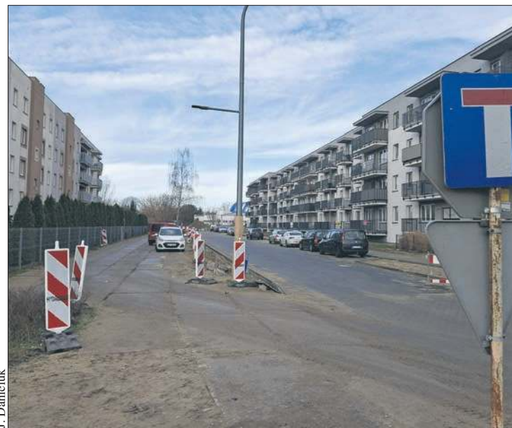
Prace na ul. Maneżowej
