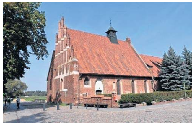
To dawny kościół św. Wawrzyńca. Po pracach konserwatorskich będzie salą wystawową
